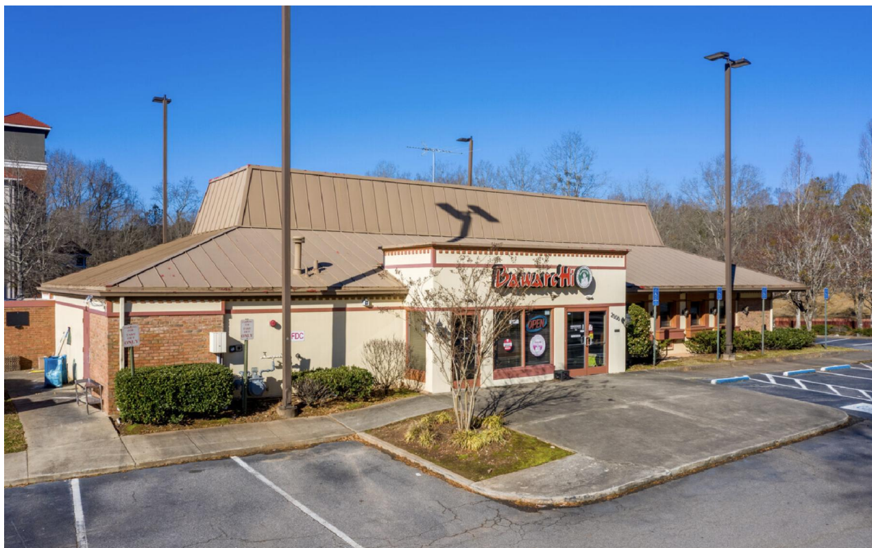
EXISTING RESTAURANT SCALE: N.T.S.
