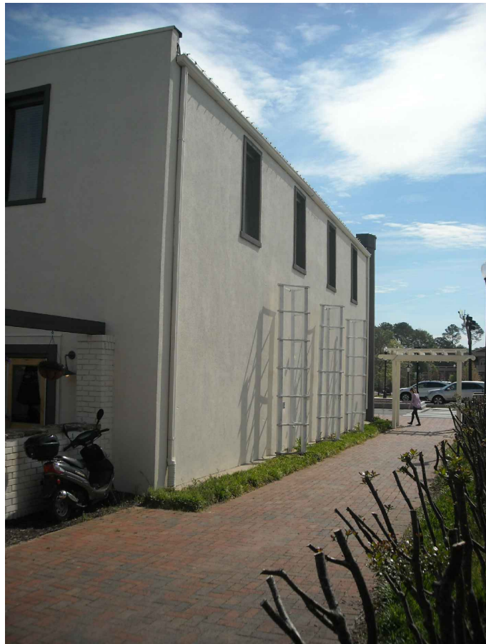
2 EXISTING EXT. PHOTO SCALE: N.T.S.
