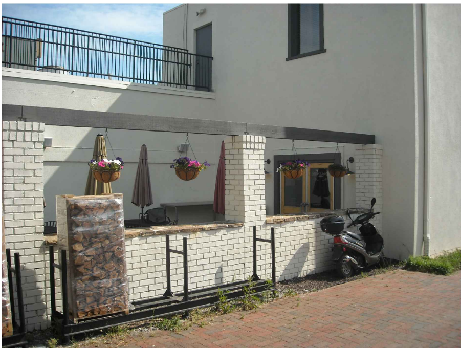
4 EXISTING EXT. PHOTO SCALE: N.T.S.
